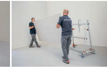
IT Carrello di movimentazione predisposto per eseguire la stesura della colla sul retro lastra. EN Handling trolleys designed to allow application of adhesive to the back of the slab.
