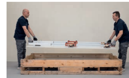
IT 3_Sollevarlo delicatamente la lastra e appoggiarla sul banco di lavoro, oppure ruotarla in posizione verticale e collocarla sul carrello di movimentazione per la stesura della colla. EN 3_Lift the slab gently and place it on the workbench, or turn it to the vertical position and place it on the handling trolley for adhesive application.
