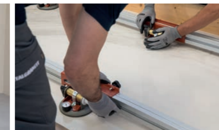
IT 2_Prima della movimentazione accertarsi che le ventose siano fissate e aderiscano perfettamente alla lastra. EN 2_Before handling, ensure that the suction cups are adhering firmly to the slab.
