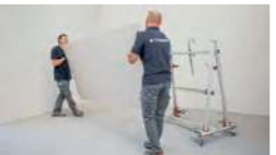
CARRELLI DI MOVIMENTAZIONE PREDISPOSTI PER ESEGUIRE LA STESURA DELLA COLLA SUL RETRO LASTRA. HANDLING TROLLEYS DESIGNED TO ALLOW APPLICATION OF ADHESIVE TO THE BACK OF THE SLAB.
